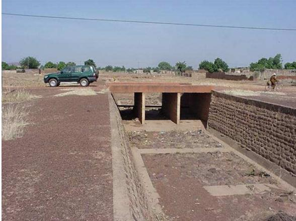
**Photo 1 :** Pont-dalot et canal de protection en aval construits en 1996 sur financement belge pour éviter la coupure d'accès à un secteur de Kaya pendant la saison de pluies.
