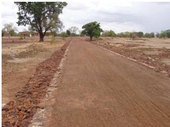
**Photo 4** : Pistes de désenclavement avec roulement latéritique
