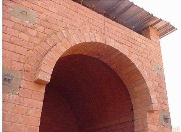
**Photo 2** : Belle construction des boutiques en voûte par des petites entreprises locales, formées sur place, évitant l'utilisation d'une charpente en bois, qui est une ressource rare au Burkina Faso.
