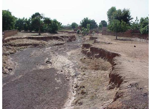
**Photo 2 :** Situation en aval du pont-dalot, montrant l'érosion causée par un écoulement très fort lors de la saison des pluies.
