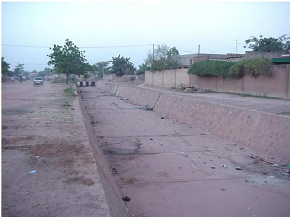
**Photo 1** : Réalisation de Faso Baara datant de 1995. Canal au secteur 19 à Ouagadougou construit en HIMO (creusement du canal par la MO locale, fond du canal en BA et berges en maçonnerie de moellons). Utilisation de pierres de Legma transporté par train de Bobo-Dioulasso à Ouagadougou.
