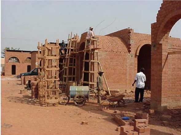
**Photo 1** : Construction du marché central de Koudougou comprenant 1210 boutiques, dont 755 déjà achevées et 619 étals à construire, utilisant des briques en terre comprimée.
