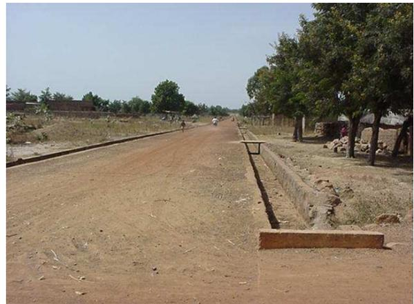
**Photo 1** : Axe Zonga – Centre Polyvalent dans la commune de Garango construit en 2002 à haute intensité de MO sur Fonds HIMO (KFW) avec Faso Baara comme MOD – Vue sur la couche de roulement en grave latéritique avec bombement correct et caniveaux réalisés en maçonnerie de moellons.
