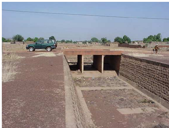
Photo 1: Pont-dalot et canal de protection en aval construits en 1996 sur financement belge pour éviter la coupure d'accès à un secteur de Kaya pendant la saison des pluies.
