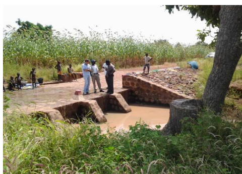
Photo 3: Ces ouvrages de franchissement sont essentiels pour désenclaver des villages.
