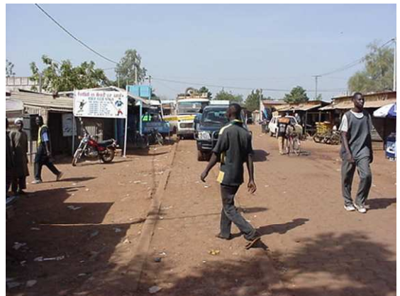
Photo 4: Aménagement de la voirie autour du marché central de Kaya en pavés de roche (abords) et en pavés autobloquants (voie centrale).
