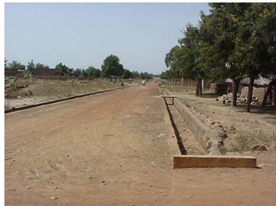
Photo 1: Axe Zonga - Centre polyvalent dans la commune de Garango construit en 2002 à haute intensité de main-d'œuvre sur Fonds HIMO (KFW) avec Faso Baara comme MOD - Vue sur la couche de roulement en grave latéritique avec bombement correct et caniveaux réalisés en maçonnerie de moellons.
