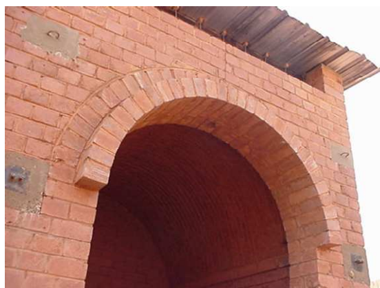
Photo 2: Belle construction des boutiques en voûte par de petites entreprises locales, formées sur place, évitant l'utilisation d'une charpente en bois, qui est une ressource rare au Burkina Faso.
