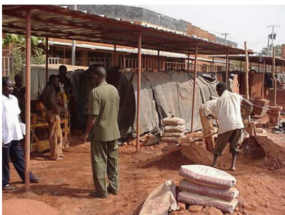
Photo 3: Production des briques en terre comprimée par de petites entreprises locales utilisant des presses manuelles.
