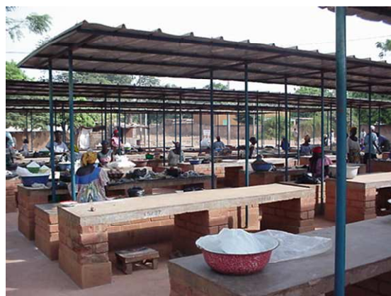
Photo 4: Marché de Zakin, très bien construit, comprenant 64 boutiques, 234 étals, 322 places au sol et une boucherie, pour un coût total de 135 millions de FCFA, partiellement opérationnel.
