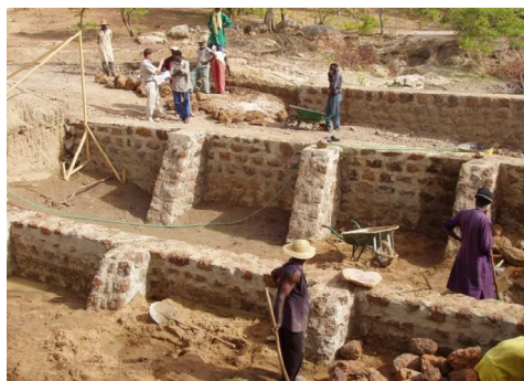
Photo 2: Construction des passages d'un radier avec un bassin de dissipation utilisant des moellons latéritiques.
