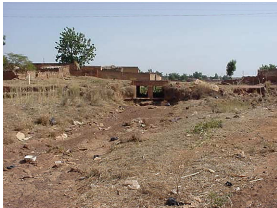
Photo 3: Situation classique à Kaya - manque d'assainissement en général.
