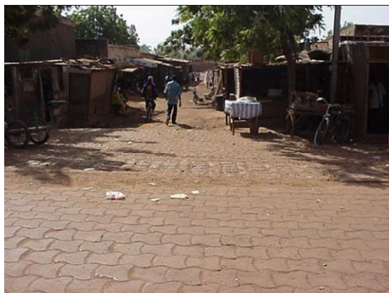
Photo 5: Voirie en pavés terminée en 1998, toujours en très bon état malgré le passage fréquent de véhicules poids-lourds.
